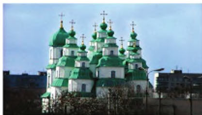
Рис. 1. Свято-Троїцький собор (1778 р.) у м. Новомосковську (Дніпропетровська обл.), побудований запорожцями з дерева без жодного залізного цвяха. Автор проекту – народний умілець Яким Погрібняк
