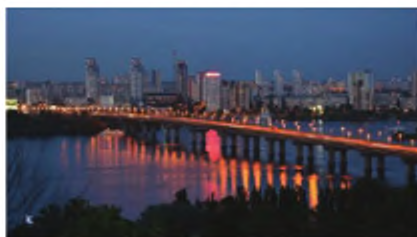
Рис. 2. Міст Патона у Києві (1940 р.) завдовжки 1543 метри – перший у світі металевий суцільнозварний міст
