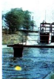
Ділянка Північно- кримського каналу
