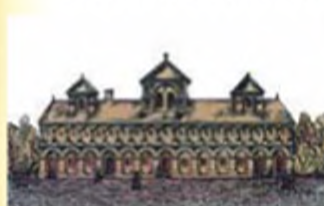
Приміщення Києво-Могилянського колегіуму
