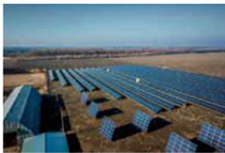
Рис. 57. Сонячна електростанція «Іванівка» (Україна)
