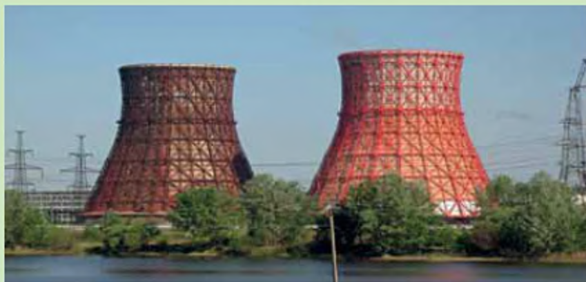
Рис. 67. Градирні на харківській теплоелектроцентралі (ТЕЦ), яка забезпечує гаряче водопостачання і опалення житлових та промислових об'єктів
